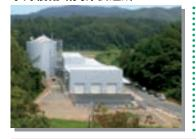
自然エネルギー発電に関する技術開発業務として新エネルギー・ 産業技術総合開発機構(NEDO)の平成15年度「新エネルギー等 地域集中実証研究しの委託先の決定を受け実証実験の受託業務を行 っております。当実証実験は、風力発電、太陽光発電、バイオガ ス発電により電力の安定供給を行うという取り組みでありますが、 当社はバイオガスによる発電業務を担当し、原料となる食物残渣 等の有機系発生品の収集・運搬とバイオガス発電プラントの運営 ・を実施し安定運用のための技術開発を行っております。
