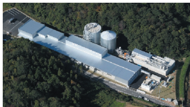
「食の循環」の取り組みが進められている京丹後循環資源製造所
